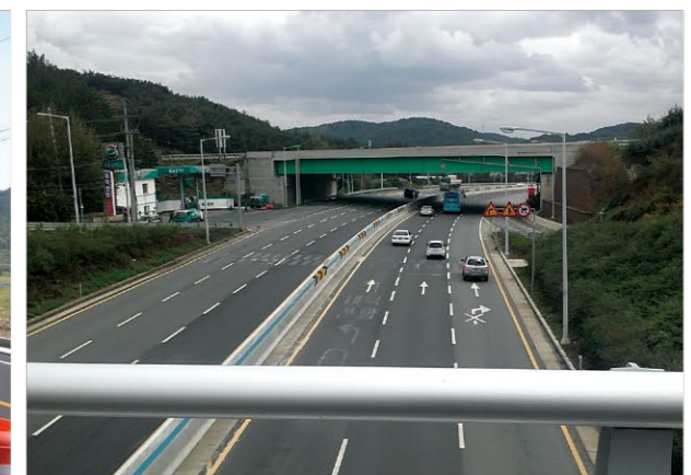
동면-장안간 연결도로 건설공사(2공구) 2004.08~2011.11
