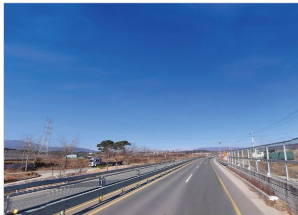
와촌-청통간 도로4차로 확포장공사 2013.05~2016.12
