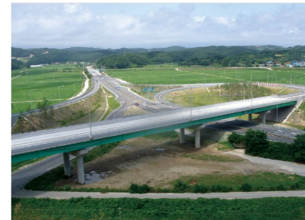
고속도로 제65호선 주문진-속초간 건설공사(3공구) 2005.08~2012.06
