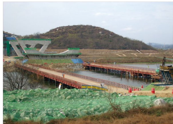
행정중심복합도시 미호천1교 토공 및 구조물공사 2010.10~2015.02
