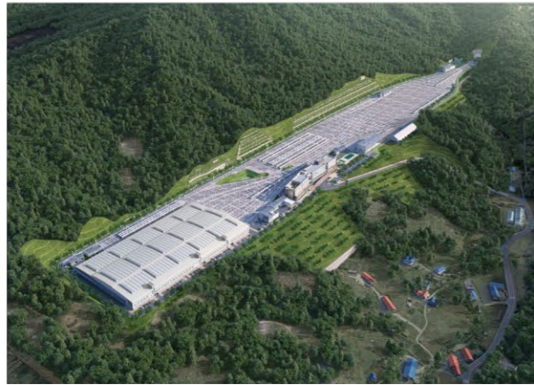
진접선 토공 및 구조물 진입도로 조성공사(2공구) 2019.10~2022.12
