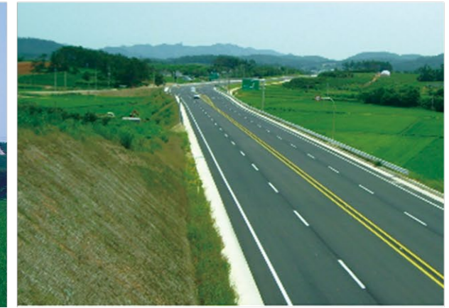
고창 상하-구시포간 지방도 확포장공사 2007.09~2012.05
