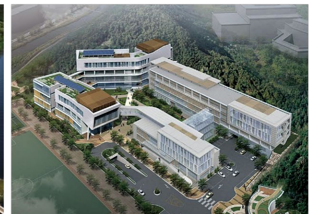
보건환경연구원 증축공사 토공 및 흙막이 공사 2009.07~2011.07
