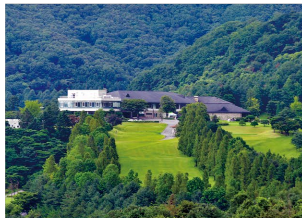
서울레이크사이드 골프장 건설공사 (9HOLE) 1988.02~1989.07
