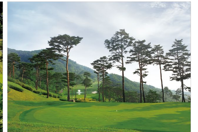
해비치CC 조성공사 (18HOLE) 2003.02~2006.09
