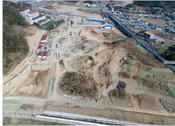
부산장안지구 택지개발사업(2단계) 조성공사 2019.06~2021.02
