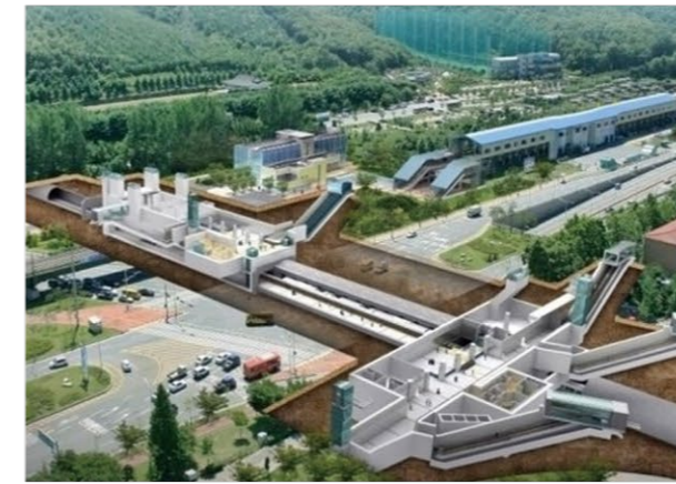
소사원시선 4공구 원곡정거장 토공 및 흙막이공사 2012.08~2018.06
