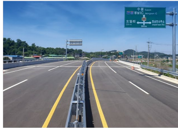
화성향남2지구 지방도 309호선 건설공사 2015.01~2020.01
