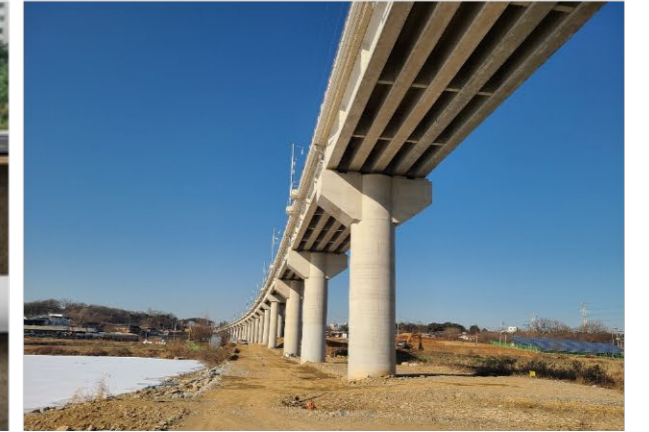
서해선 복선전철 9공구 토공 및 구조물공사(3구간) 2018.02~2021.06
