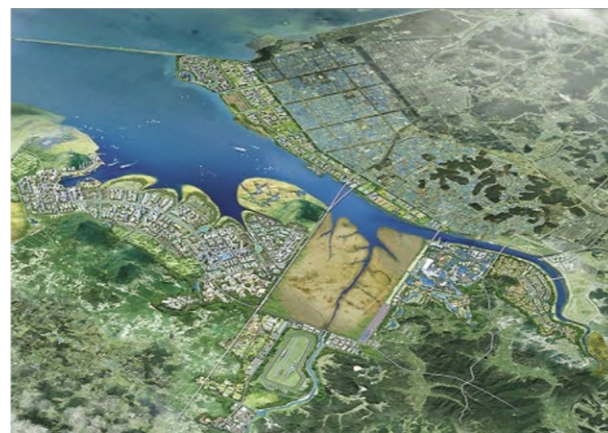
송산동서진입도로 건설공사 토공 및 흙막이공사 2012.11~2019.07
