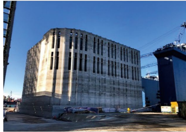
울산신항 남방파제 축조공사 중 케이슨제작공사 2020.05~2022.03
