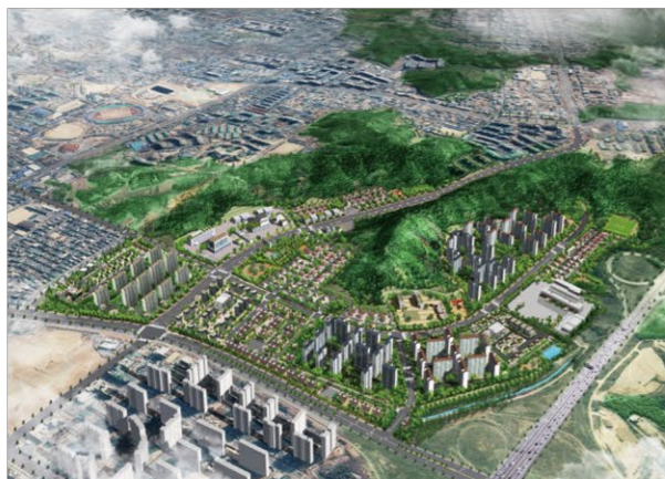
원주무실 2지구 택지개발사업 조성공사 2007.09~2011.07
