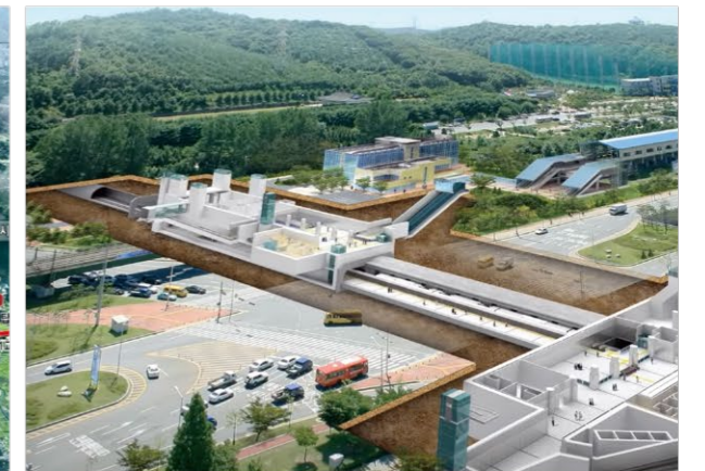
소사원시복선전철 4공구 노반공사 4-2구간 2012.08~2018.06
