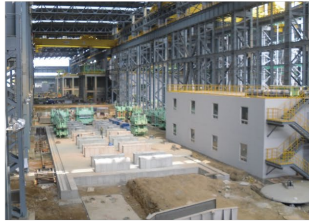
일관제철소 건설공사 중 후판공장 토목공사 2008.03~2010.09
