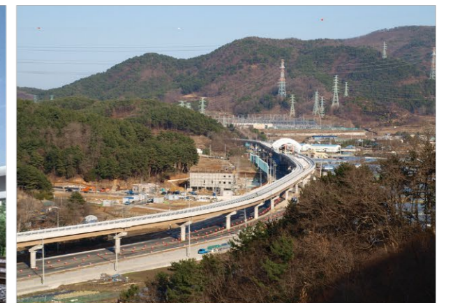
부산지하철 3호선 2단계 328공구 토목공사 2005.11~2010.12
