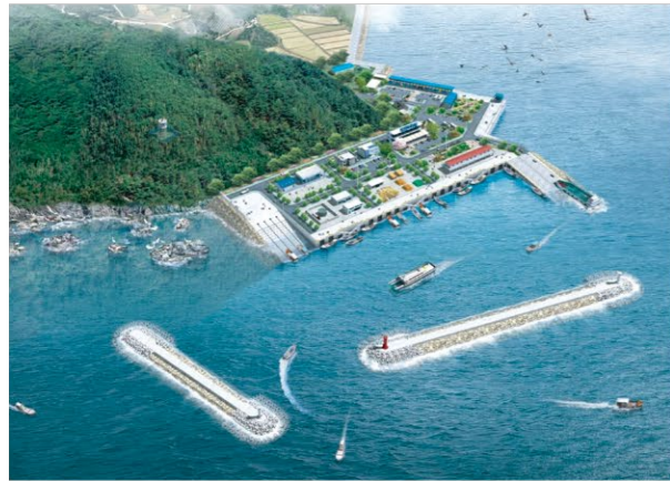
여유정항 정비공사 중 방파제 및 접안 시설 축조공사 2007.10~2016.02
