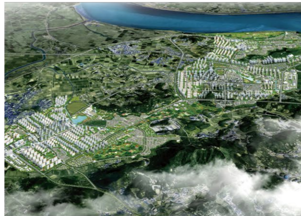
김포한강지구 택지개발사업 조성공사 (6공구) 2008.12~2014.12
