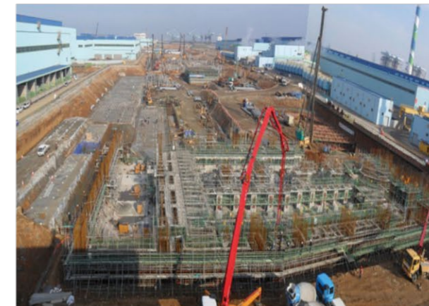
일관제철소 3기 건설 후판공장2 토공 및 흙막이공사 2011.08~2013.12
