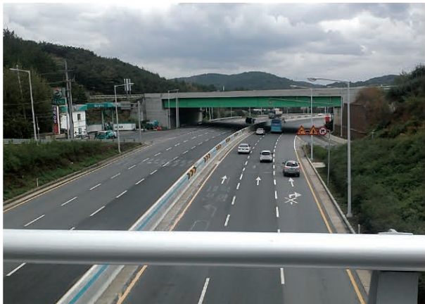
동면-장안간 연결도로 건설공사(2공구) 2004.08~2011.11
