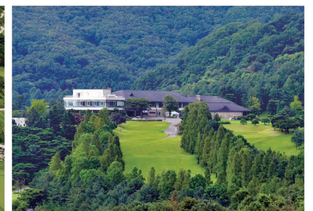
서울레이크사이드 골프장 건설공사 (9HOLE) 1988.02~1989.07
