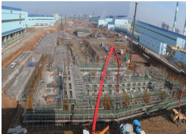
일관제철소 3기 건설 후판공장2 토공 및 흙막이공사 2011.08~2013.12
