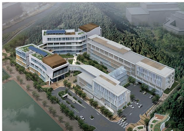
보건환경연구원 증축공사 토공 및 흙막이 공사 2009.07~2011.07
