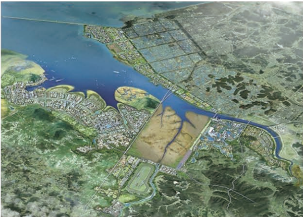
송산동서진입도로 건설공사 토공 및 흙막이공사 2012.11~2019.07
