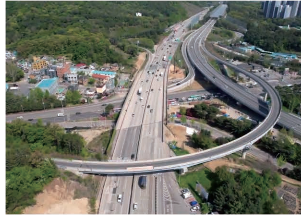
영동선 안산-북수원간 확장공사(2공구) 2012.04~2027.12
