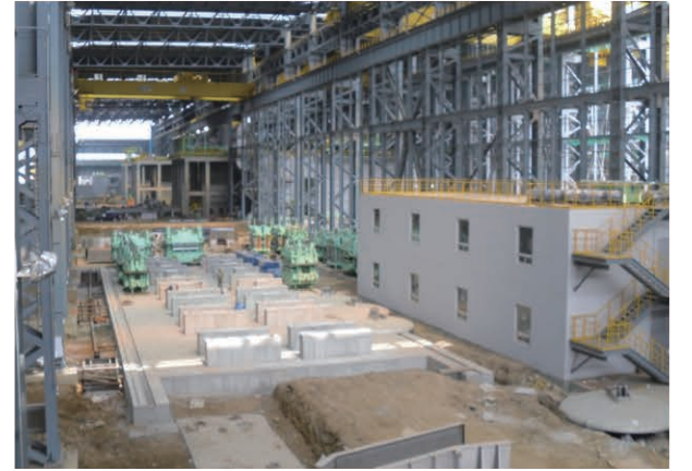
일관제철소 건설공사 중 후판공장 토목공사 2008.03~2010.09
