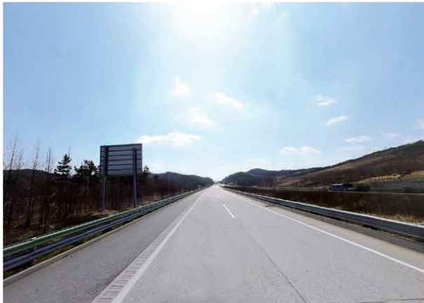
고속국도 제27호선 전주-광양간 건설공사(4공구) 2005.04~2010.12
