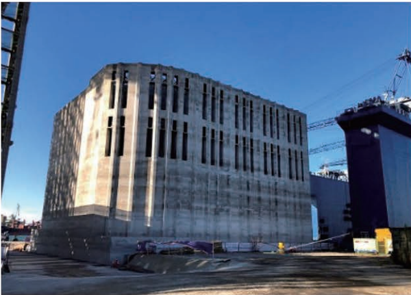
울산신항 남방파제 축조공사 중 케이슨제작공사 2020.05~2022.03
