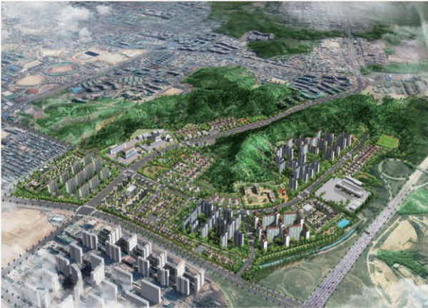
원주무실 2지구 택지개발사업 조성공사 2007.09~2011.07
