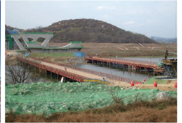
행정중심복합도시 미호천1교 토공 및 구조물공사 2010.10~2015.02
