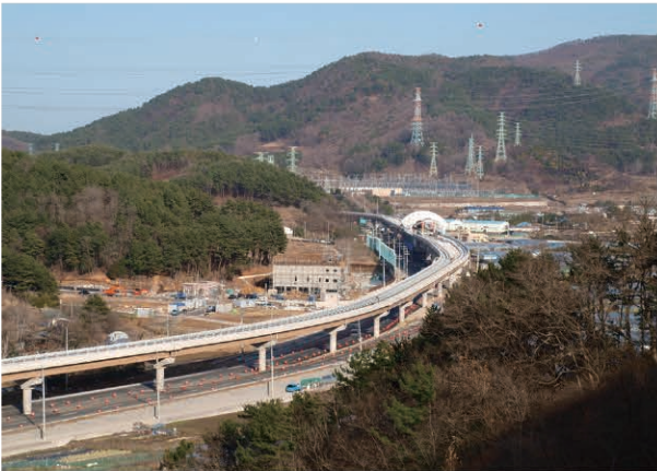
부산지하철 3호선 2단계 328공구 토목공사 2005.11~2010.12
