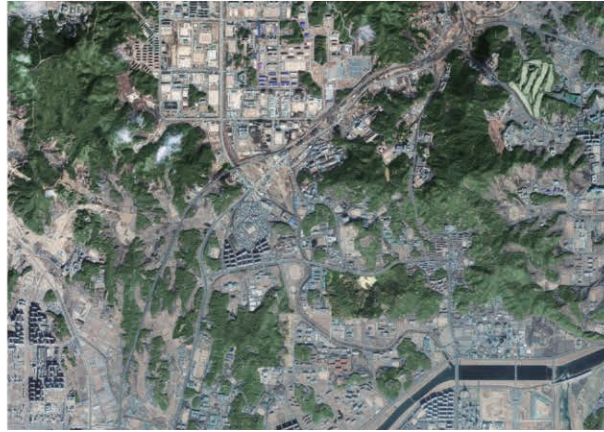
대덕연구개발특구 죽동배수지 토공 및 흙막이공사 2011.08~2018.06
