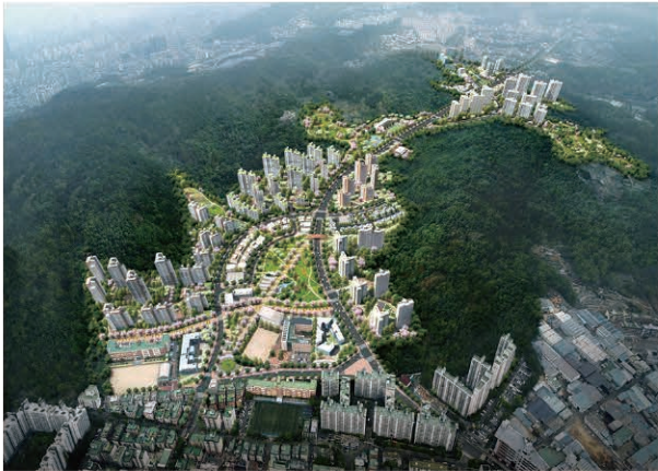
부천역곡 공공주택지구 조성공사 2025.04~2027.12
