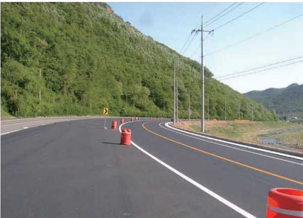
청도-경산간 도로4차로 확장공사 2004.12~2015.01
