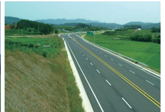
고창 상하-구시포간 지방도 확포장공사 2007.09~2012.05
