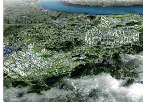
김포한강지구 조성공사 (6공구) 토공 및 흙막이공사 2008.12~2014.12
