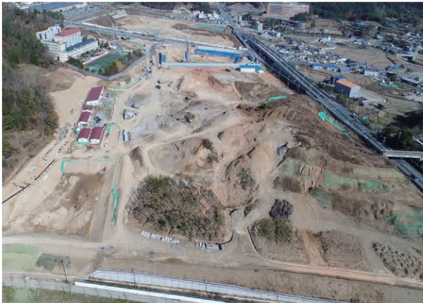
부산장안지구 택지개발사업(2단계) 조성공사 2019.06~2021.02
