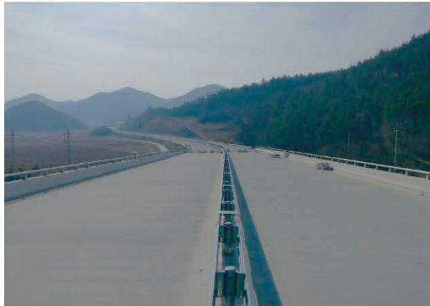
화양-나진간 지방도 확포장공사 및 흙막이공사 2013.11~2018.12
