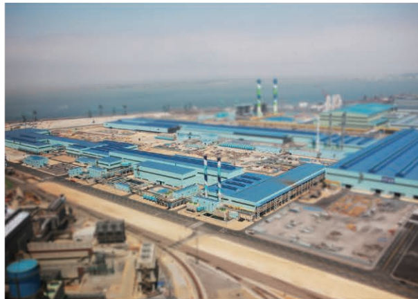
일관제철소 3기 건설 토목공사 중 연주공장 2011.05~2013.12
