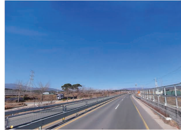
와촌-청통간 도로4차로 확포장공사 2013.05~2016.12
