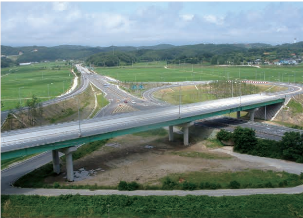
고속도로 제65호선 주문진-속초간 건설공사(3공구) 2005.08~2012.06
